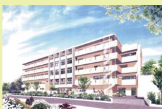
アイホームまつど中央。都心からも通いやすい高い利便性を誇る。全85室と、比較的大きなホームである
