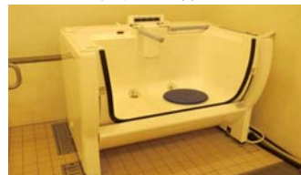
座ったまま入浴できる機械浴槽
